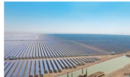
光伏和风电-宁夏太阳山10MW地面电站
